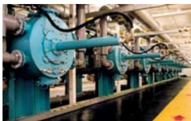
Двухступенчатая фильтрация воды для снижения содержания криптоспоридий на 4 порядка (875 м 3 /час)
