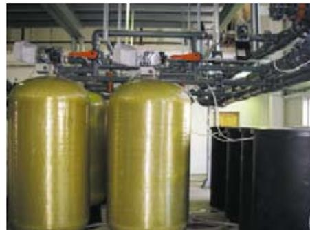
Автоматизированные системы для умягчения воды и удаления растворенного железа
