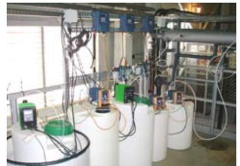
Комплексы дозирования реагентов для обработки подпиточной и питательной воды паровых котлов
